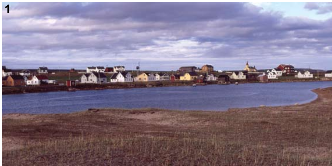
Figur 1. Bygda Skallelv har en utpreget landsbystruktur, og skiller seg i så måte klart fra det som er vanlig i Norge. Det samme gjelder byggeskikken, med mange varangerhus, hvor bolighus og fjøs henger sammen. Befolkningen har i all hovedsak finske røtter. The local community Skallelv has a pronounced village structure, thereby differing markedly from what is common in Norway. The same regards the building traditions. There are many Varanger-style houses, in which the dwelling house and the barn are built together. The population is mainly of Finnish descent.
