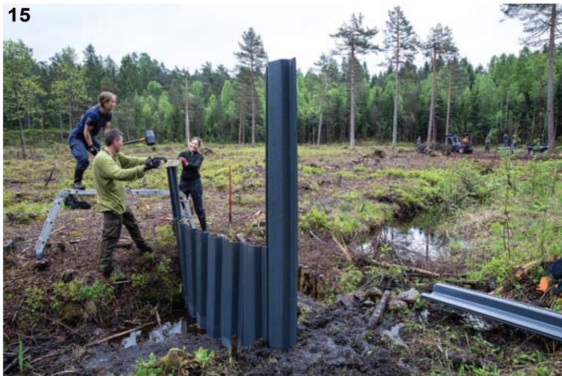
Figur 15. 30. mai 2013 ble flere demninger slått ned for å heve vannstanden i myra. Dette var mer enn 40 år etter at Asbjørn Moen og Finn Wischmann skrev at gjenfylling av grøftene var en betingelse for vern (Moen og Wischmann 1972). Tiltaket ser ut til å være vellykket. Foto: Kim Abel/Naturarkivet.no.
