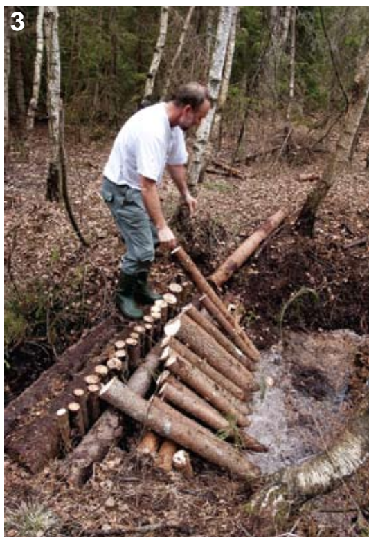
Figur 3. Gammel demning fra 2002 som ikke holdt tett. Foto: Kim Abel/Naturarkivet.no.
