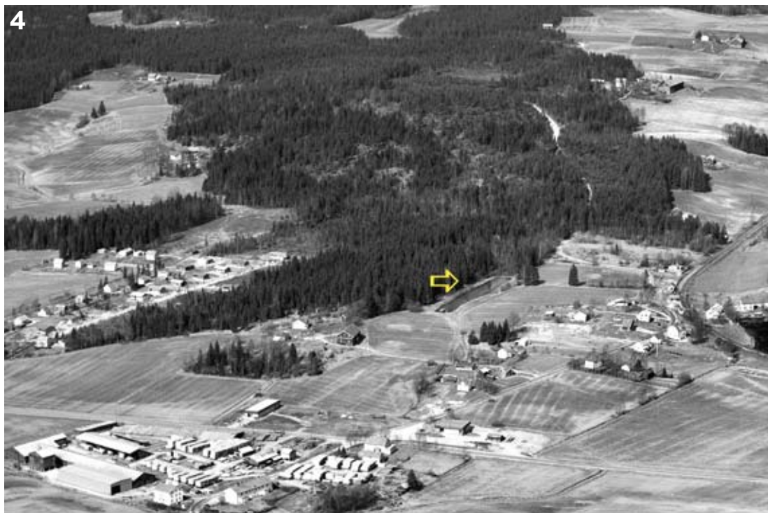
Figur 4. Knapstad Sag & Høvleri i 1968. Det kan se ut til at vegetasjonen rundt Bøhlebrønnen (se pila midt på bildet) ble holdt nede og at vannspeilet var større. Foto (utsnitt): Widerøe's Flyveselskap A/S / Østfold fylkes billedarkiv (eier: Hobøl historielag) Aerial photo of the saw and planing mill from 1968. It appears that the vegetation around the pond Bøhlebrønnen (see the arrow in the middle of the photo) was attended to, and the expanse of water was clearly larger than today.
