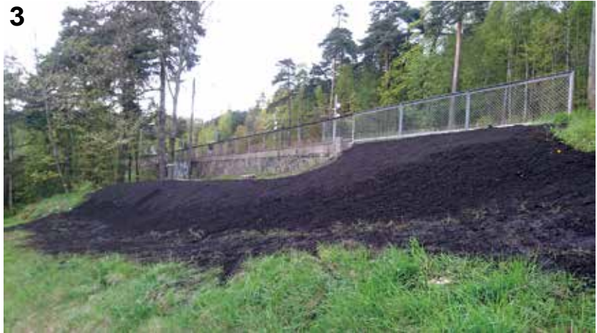
Figur 3. Lokaliteten ved Sjømannsskolen rett etter at den ble dekket til med rotlag fra Oslokompost. Foto: THK 11.5.2017.
