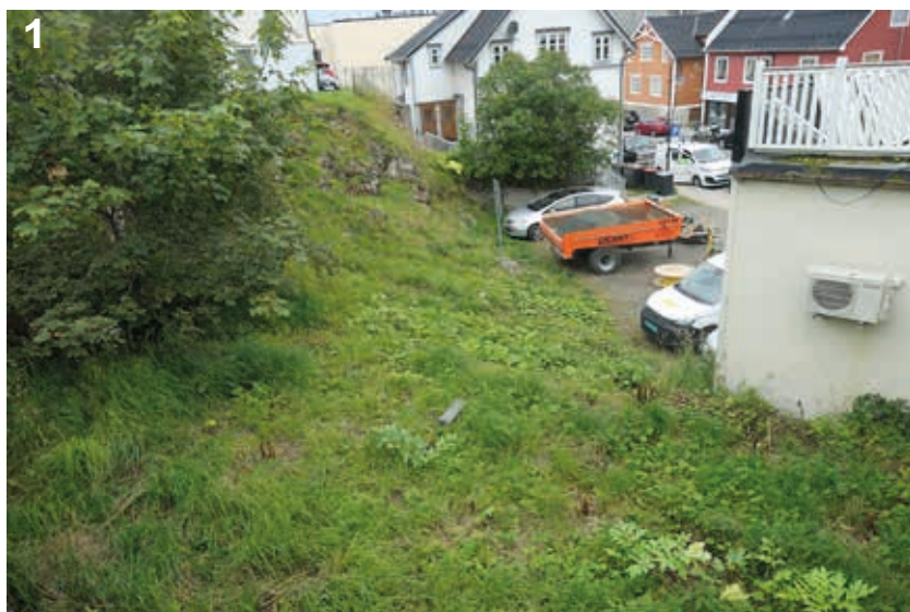
Figur 1. Skrenten i Havnegata sett ovenfra. Foto: TA 29.08.2021.
