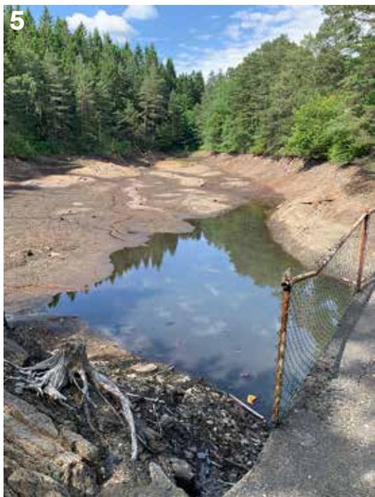
Figur 5. Dammen etter tømning, juni 2022. Foto: PF. 30.06.2022.
