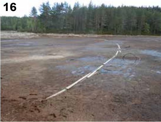
Figur 16. Plankebruene gjorde det mulig å nå sprederne og justere dem. Foto: RG 26.05.2020.
