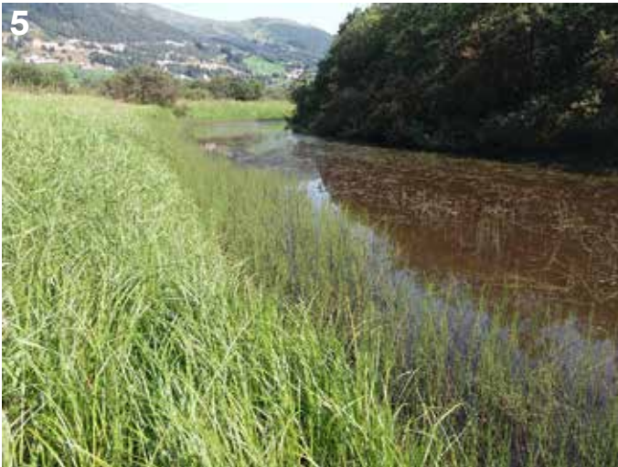
Figur 5. Kanalene som ble gravd ut var ca. 4 m brede og 2 m på det dypeste. Langs kantene av kanalene har det mange steder blitt utviklet en tett og frodig vegetasjon, både over og under midlere sommervannstand. Til høyre i bildet ligger en konstruert øy, fullstendig dominert av skog. Kanalene ligger beskyttet mot vind og bølgeerosjon og derfor har også elvesnelle dannet tette bestander ned til mer enn 60 cm under vannstanden. I kanalene fantes tjoenaks Potamogeton - og piggeknopt Sparganium -arter flere steder. Foto: AO. The channels that were excavated were approx. 4 m wide and 2 m at their deepest. Along the edges of the canals, dense and luxuriant vegetation has developed in many places, both above and below average summer water levels. To the right of the picture is a constructed island, completely dominated by forest. The canals are protected from wind and wave erosion and therefore also Equisetum fluviatile has formed dense populations down to more than 60 cm below the water level. In the canals, Potamogeton and Sparganium species were found in several places.
